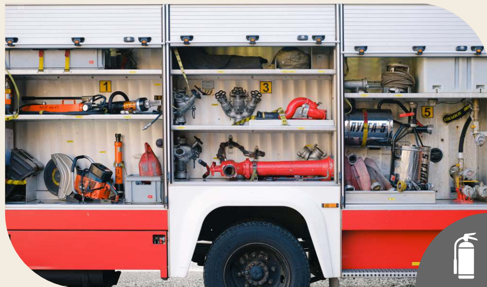
Dilengkapi Unit Pemadam Kebakaran Di Dalam Kawasan
